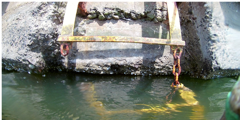
Zdjęcie nr 6 - drabinka dolne mocowanie jest pęknięte
