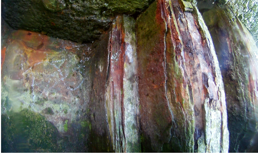
Zdjęcie podwodne nr 6 - widok nieuszczelnionego przejścia przez ściankę kolektora
