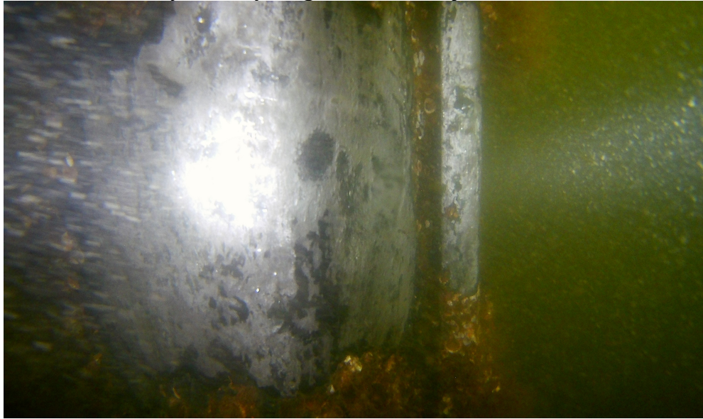
Zdjęcie podwodne nr 5 - oczyszczony fragment stalowej ścianki.
