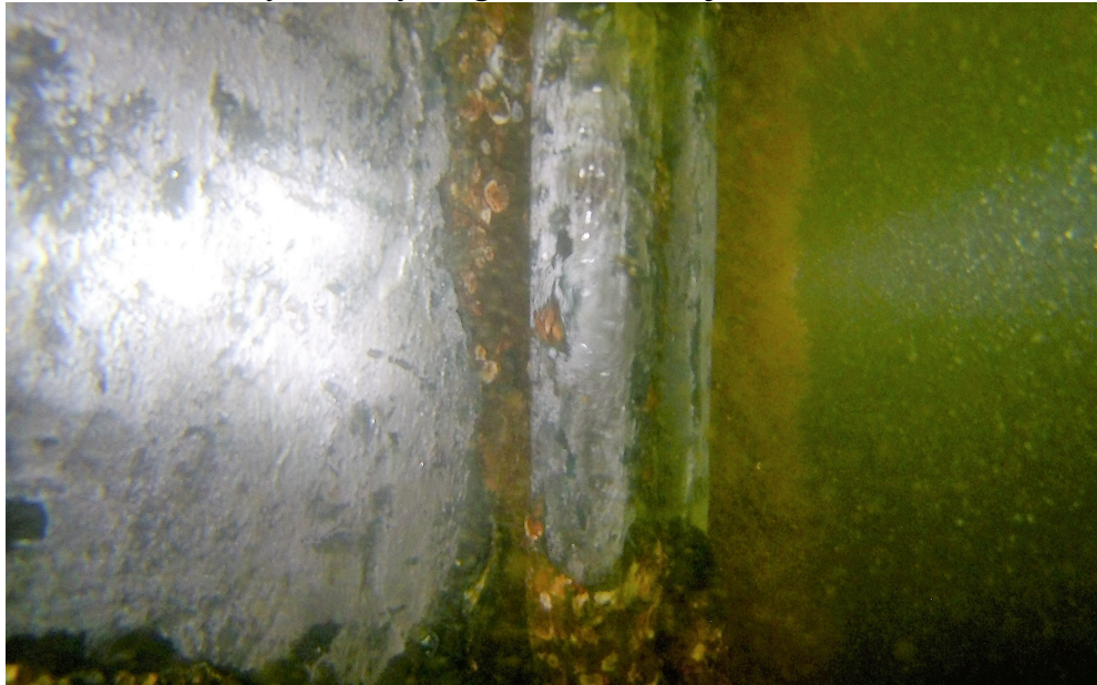
Zdjęcie nr 6 - drabinka dolne mocowanie jest pęknięte
