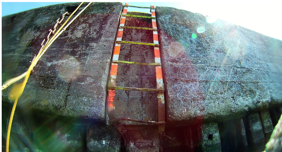
Zdjęcie nr 7 - drabinka mocno podgięta na dole, brak części podwodnej.
