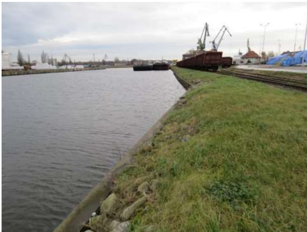
Fot.5. Basen Notecki i okalające Nabrzeża w złym stanie technicznym. Basen przeznaczony do załadunku i zasypania urobkiem.
