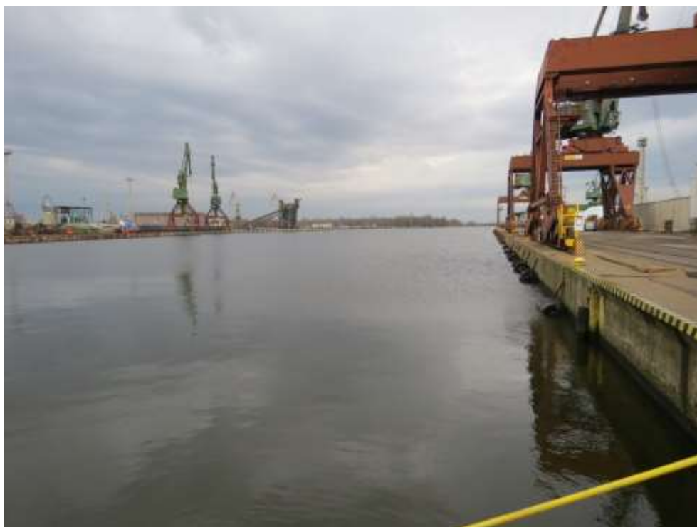
Fot.4. Basen Kaszubski wymagający pogłębienia do głębokości 12,5 m i stworzenia obrotnicy w centrum i na wejściu do Basenu oraz umocnienia nabrzeży.
